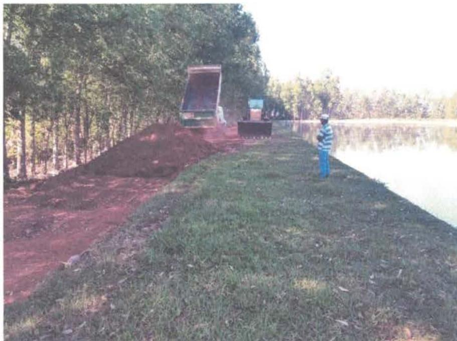
Foto 02 - Terraplanagem na margem da lagoa facultativa - ETE Tabapuã (futura área do leito de secagem e acondicionamento dos geobags)
