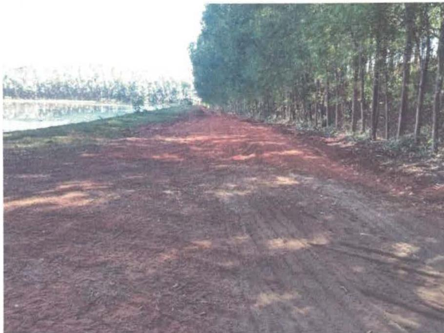
Foto 01 - Terraplanagem na margem da lagoa facultativa - ETE Tabapuã (futura área do leito de secagem e acondicionamento dos geobags)
