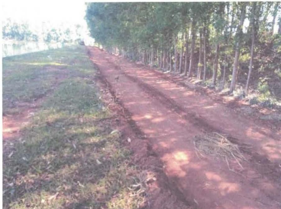
Foto 03 - Terraplanagem na margem da lagoa facultativa - ETE Tabapuã (futura área do leito de secagem e acondicionamento dos geobags)
